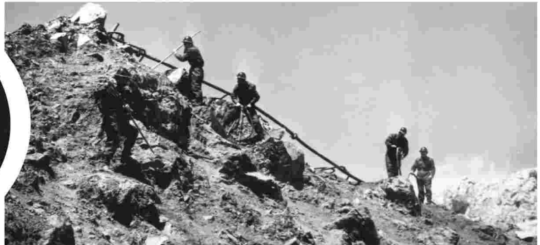
Başlangıçta dinamit ile parçalanmış maden blokları sonraki yıllarda amonyum nitrat, azot gübresi ve mazot karışımı ile 30 cm çaplı deliklere doldurularak demir kayası daha etkin ve ucuz olarak parçalanıyordu.
